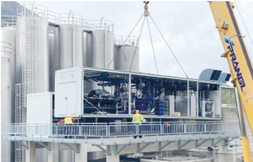
Auf mit Pfeilern abgestützten Fundamenten wurden in luftiger Höhe die drei Module der ONI-Container-Kühlanlage zu einer Einheit zusammengesetzt. Hier wird das zweite Modul der Anlage millimetergenau eingepasst
