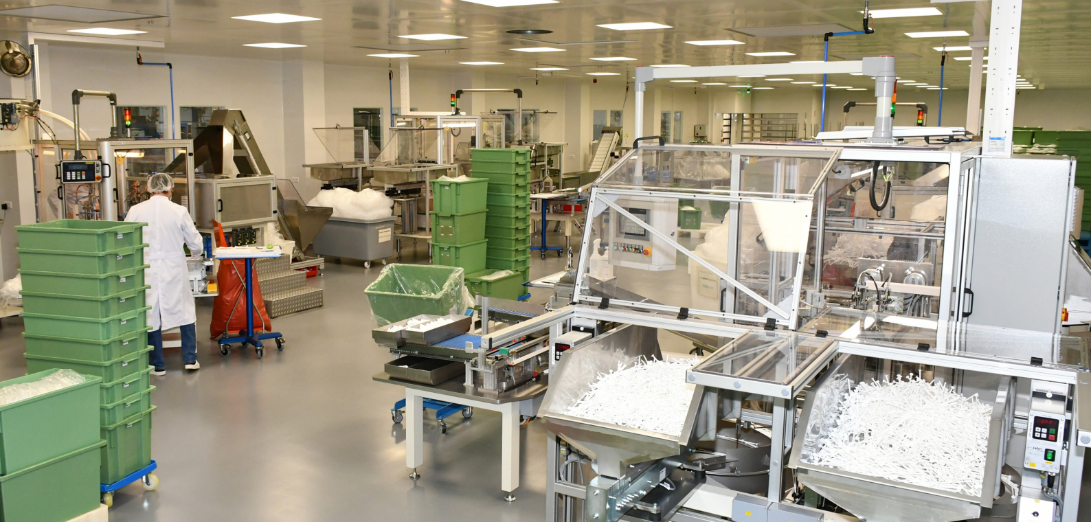
Blick in den kürzlich fertiggestellten Reinraum der ISO-Klasse 8, im kleinen Bild das zentrale Klimagerät für die Versorgung des Reinraums. Das Klimagerät ist mit einem Kühlregister zur Kühlung und Entfeuchtung, einem Heizregister zur Nutzung von Abwärme, Filtereinheiten zur Reduzierung der Partikelanzahl sowie einer Befeuchtungseinheit für den Winterbetrieb ausgerüstet. Bilder: ONI
