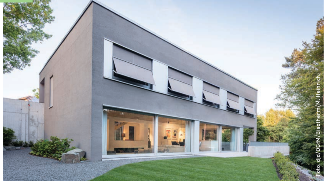
Massives Mauerwerk sorgt nicht nur ganzjährig für angenehme Temperaturen, sondern bietet soliden, wertbeständigen Wohnraum für Generationen.
