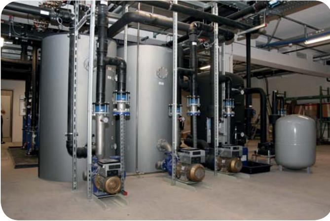
Druckbehälterkombination für die Kühlung der Maschinenhydraulik bei gleichzeitiger Nutzung der Abwärme für Heizzwecke in den Übergangs- und Wintermonaten. Der Zeit voraus ist die Entscheidung der Wehrle Geschäftsführung zum Einsatz hoch effizienter Pumpen mit frequenzgeregelten IE4 Motoren. (Bild: Oni)
