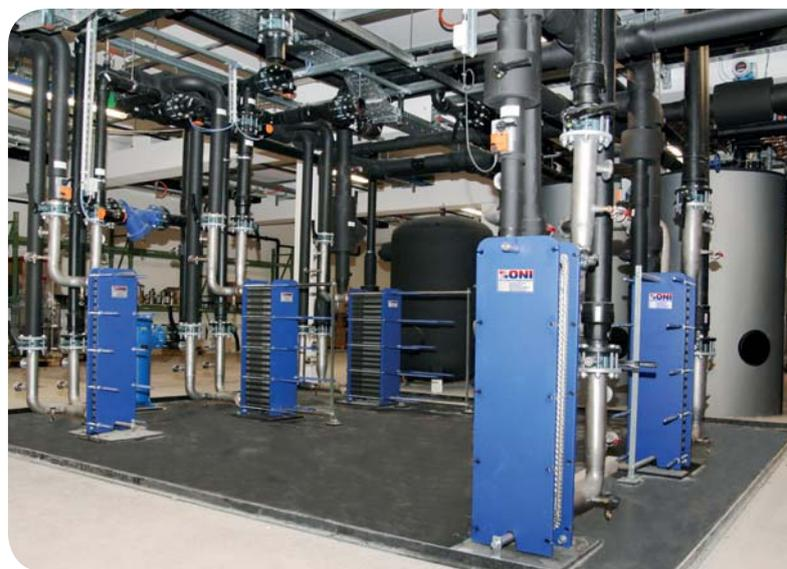
Für erhöhte Betriebssicherheit sorgen redundant ausgelegte Systemkomponenten wie die Wärmeaustauscher für die Versorgung der einzelnen Kühlkreisläufe, die in einem Bereich der Energiezentrale zusammengefasst wurden. (Bild: Oni)
