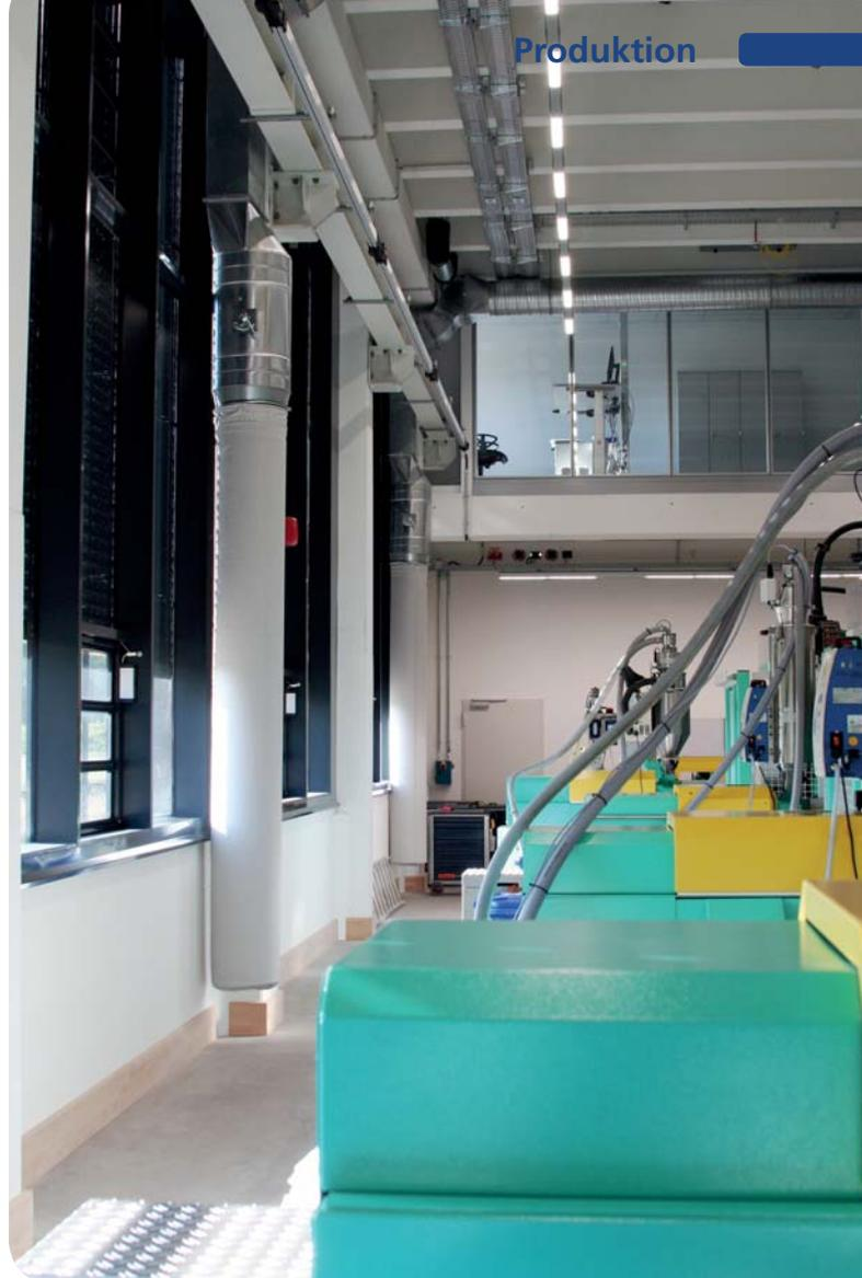
Über Quellluftschläuche wird Frischluft ohne störende Verwirbelungen und mit niedrigen Strömungsgeschwindigkeiten gezielt in thermisch hoch belastete Produktionsbereiche eingebracht. (Bild Wehrle)
