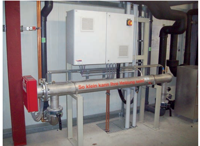
Heizpatrone als Defizitheizung – wenn die Spritzgießmaschinen zwischen Weihnachten und Neujahr keine Abwärme für Heizzwecke liefern.
