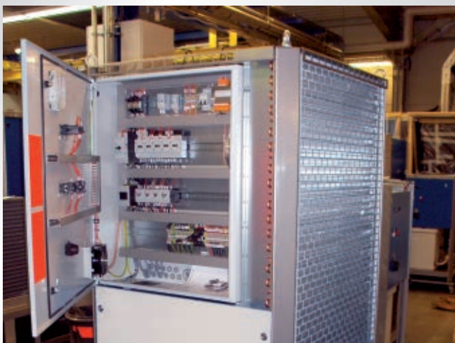
"Gut organisiert und bestens geregelt": Blick in den Schaltschrank einer ONI Kompakt-Kältemaschine "Organized well and arranged in the best way": view into the switchgear cabinet of a compact ONI chiller
