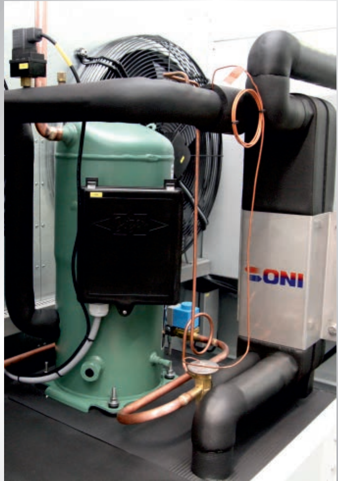
Bitzer-Kompressor mit Platten-Verdampfereinheit
