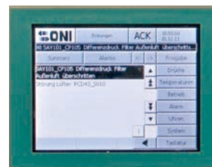
Am zentralen Steuerstand oder an den dezentralen Steuerungen werden – hier simulierte – Störungsmeldungen im Klartext ausgegeben. Dabei bleibt die Funktionsfähigkeit aller Kreisläufe stets gewährleistet.
