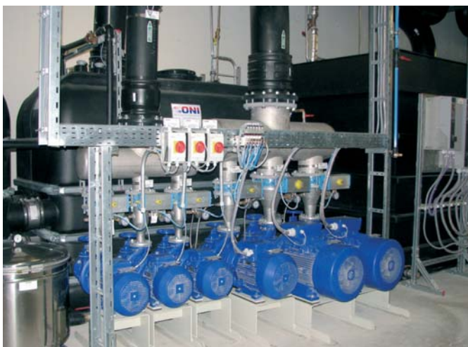
Pumpen-Tankeinheit zur Kühlwasserversorgung der Spritzgieß- und Kältemaschinen mit Energieoptimierung durch eine Wärmerückgewinnung.
