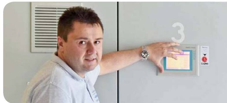
Trotz der Komplexität ist die „Energiesparzentrale“ bei Schneegans-Freudenberg sehr kompakt und wartungsfreundlich. (Bild: Droege)
