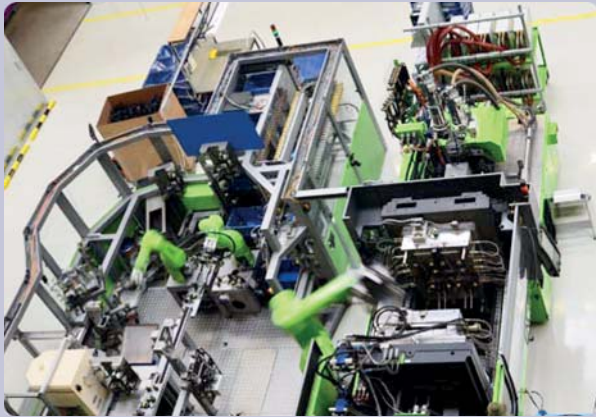
Die zentrale Steuerung der gesamten Kühl- und Heiztechnik der Produktion und Verwaltungsbereiche ist in einfach zu bedienenden Steuerungsoberflächen abgebildet. (Bild: Droege)
