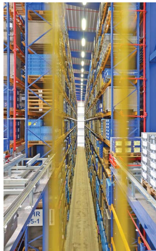
Trotz hoher Belastungen durch Regale und Flurförderzeuge wurde eine Fußbodenheizung als effizienteste Beheizungs-methode gewählt.
