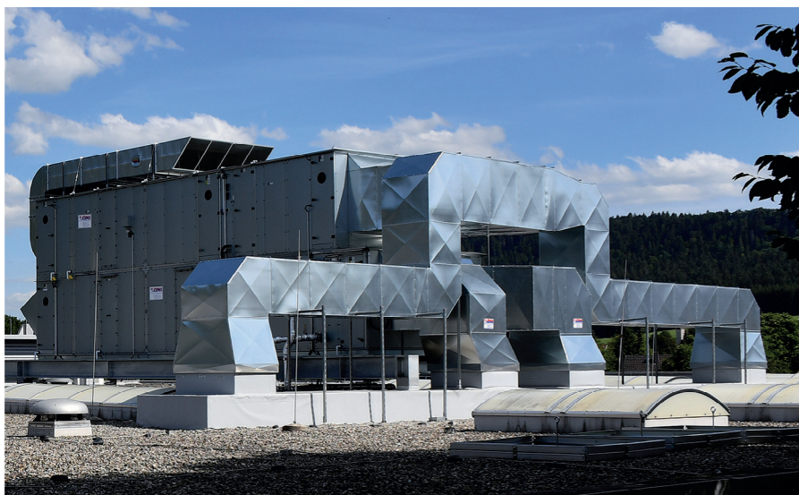
Zentrale Lüftungsanlage mit zweistufiger Wärmerückgewinnung zur Nutzung von Abwärme aus der Abluft und aus dem Kühlwasserkreislauf der Spritzgießmaschinen.
